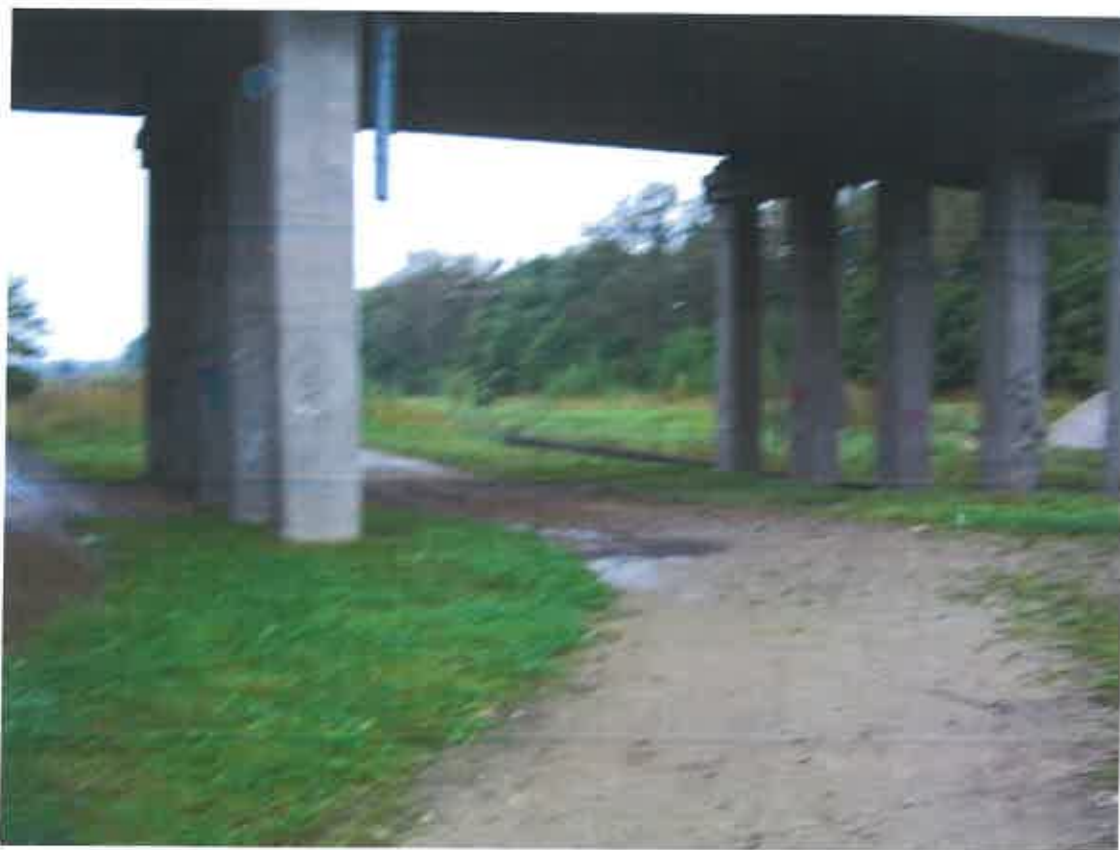
Foto 3. Vaade kohale, kust rajatav F.R. Kreutzwaldi tn ja Jaama pst ühendav ramp läbib T5 Pärnu- Rakvere Sõmeru maantee ja Tapa- Narva raudtee viadukti.
