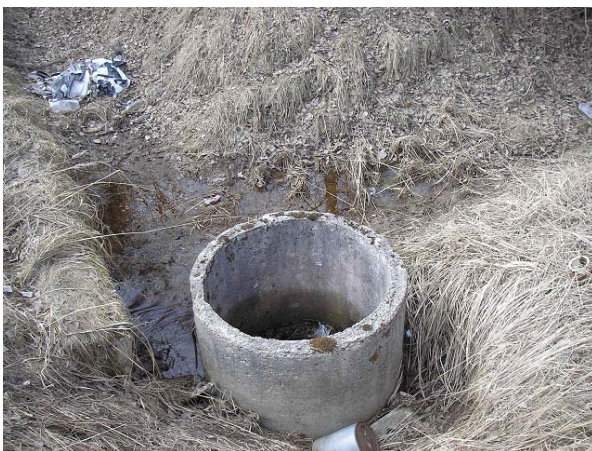
Foto 5. Kogumiskaev Kanepi-Leevaku tugimaantee ääres
