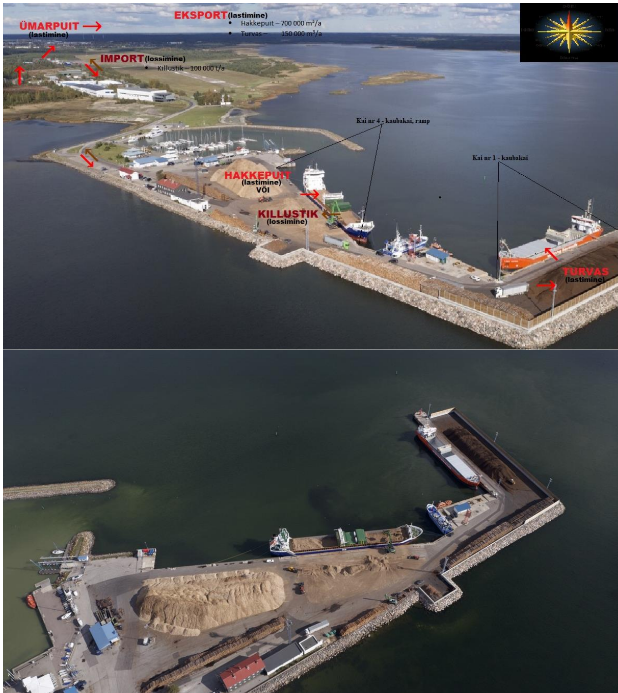
Joonis 3. Turba ladustamine ja lastimine toimub kaubakail nr 1. Hakkepuudu ladustamine ja lastimine ning killustiku lossimine toimub kaubakail nr 4. Hakkepuudu lastimist ja killustiku lossimist kaubakail nr 4 üheaegselt ei toimu.
