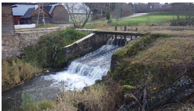
Foto 1. Vaade paisu veelaskmele (P. Napp 20.11.2020)
